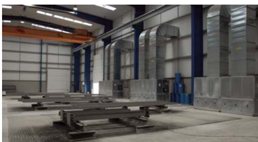
Interior de la nave durante el montaje
