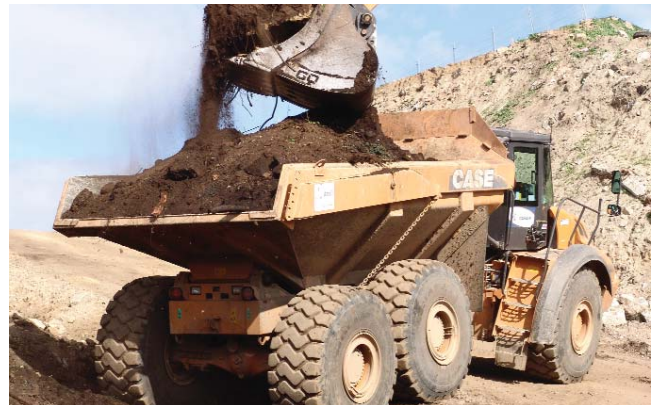
Los dúmperes CASE 340B en tareas de carga y transporte en las obras de la Tercera Ronda de A Coruña.
